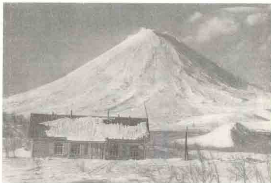
Фиг. 1. Здание сейсмической станции.
